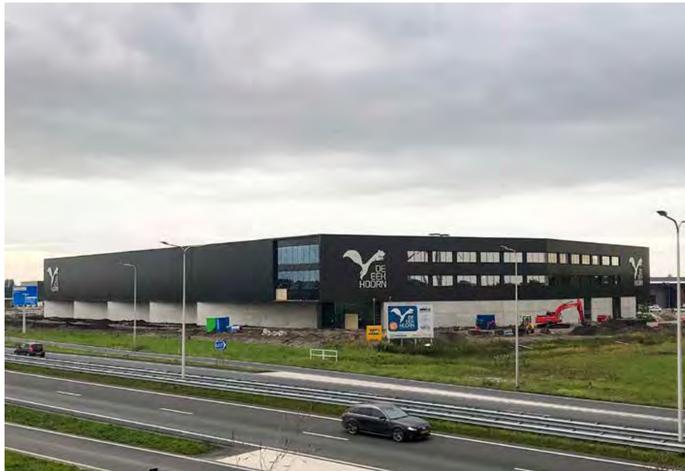
Breg Ontwerp en Advies maakte het gebouwontwerp, waarbij de robuuste betonnen plint – van maar liefst 5 meter hoog – fraai contrasteert met de strakke, zwarte opbouw.
