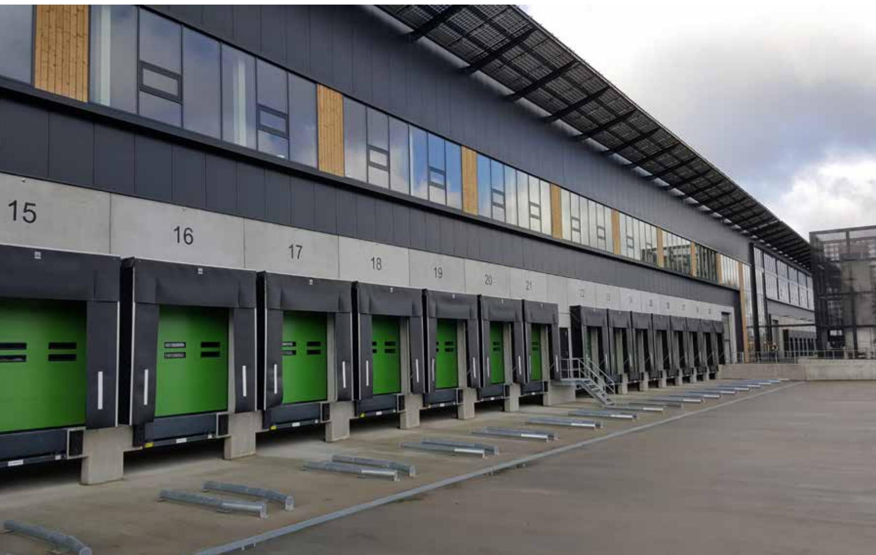
Luifel van glazen PV-panelen over de voorgevel.
