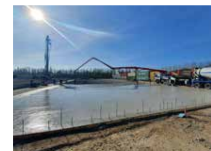
Starten van de begane grondvloer.
